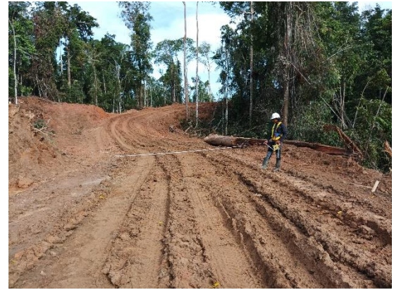
Gambar 11. Realisasi Pembuatan Jalan di Blok RKT 2024
