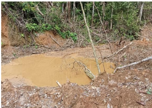
Gambar 38. Pembuatan Sedimen pool di Blok RKT 2024
