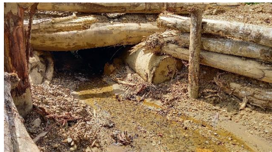
Gambar 12. Pembuatan Turap, Parit, Sedimen Pond
