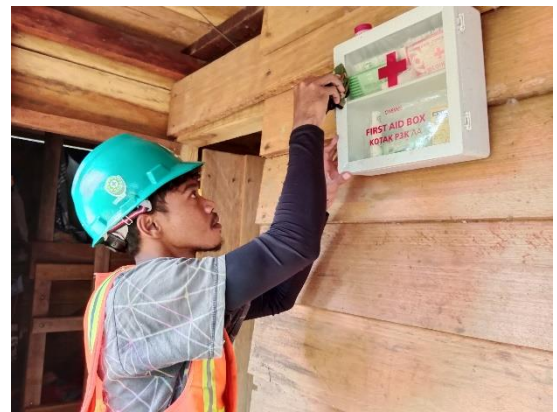
Gambar 27. Fasilitas Kotak P3K disetiap mess Karyawan
