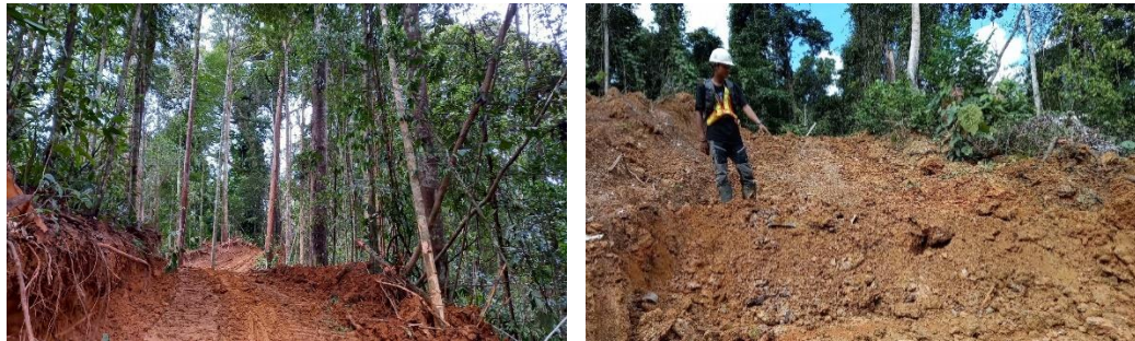
Gambar 13 dan 14. Kondisi Jalan Sarad dan Tindakan Pasca Tebangan (Pembuatan Sudetan)
