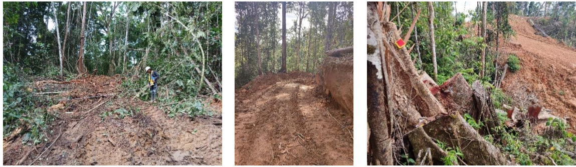
Gambar 41, 42, 43. Rata – rata lebar jalan sarad 4.5 m, deaktivasi jalan sarad (pembuatan sudetan), tinggi tunggak penebangan ±50 cm
